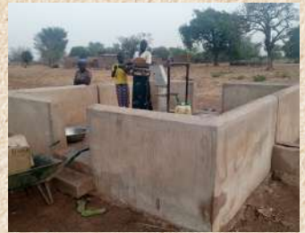
Forage doté d'une pompe manuelle rénové au Burkina Faso.
