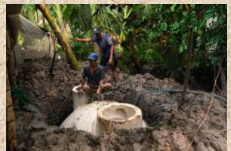
Installation de fosses à biogaz au Vietnam.
